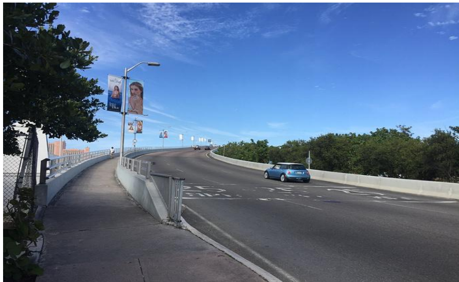
拿骚天堂岛高架桥
